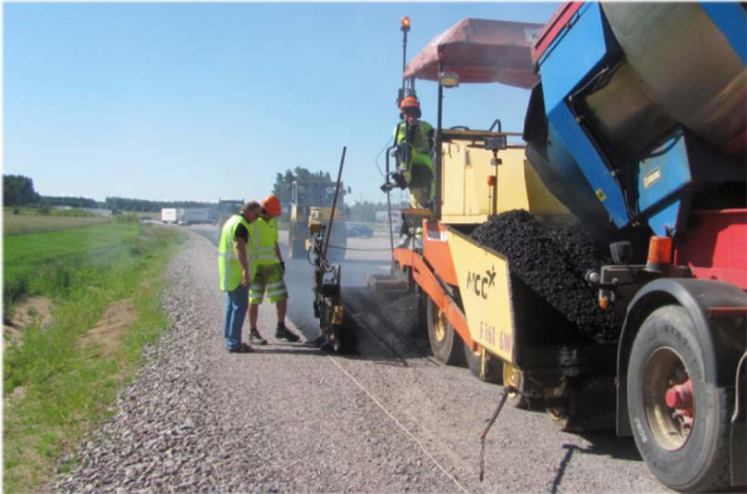
Figur 7. Läggnig av bundet bärlager: sträcka c-x.
