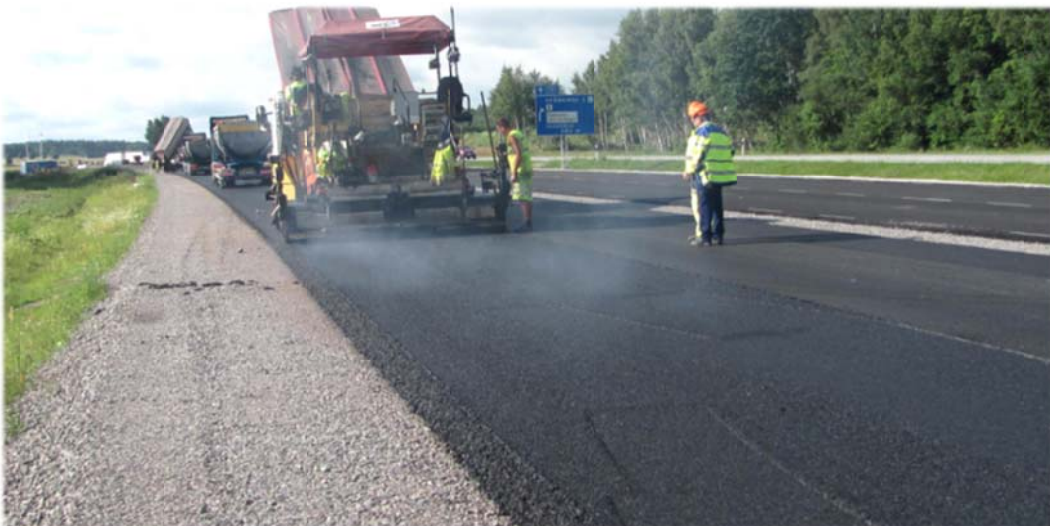
Figur 8. Läggnig av bindlager: sträcka (1).
