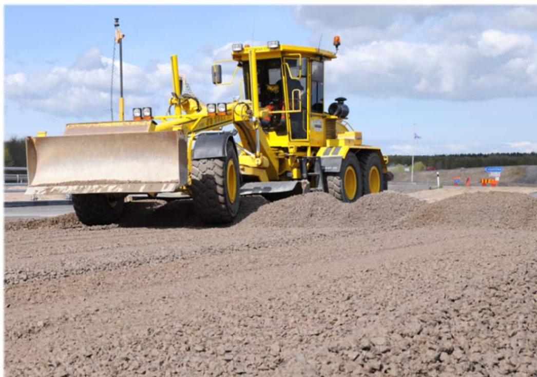
Figur 6. Utförande av obundet bärlager, strax norr om provsträckan.
