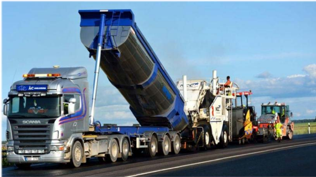
Figur 9. Läggnig av slitlager: sträcka abc.
